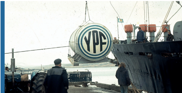
INSTALACIÓN DE LA PLANTA DE COMBUSTIBLES "ANTARES" DE YPF EN MALVINAS (1974)
